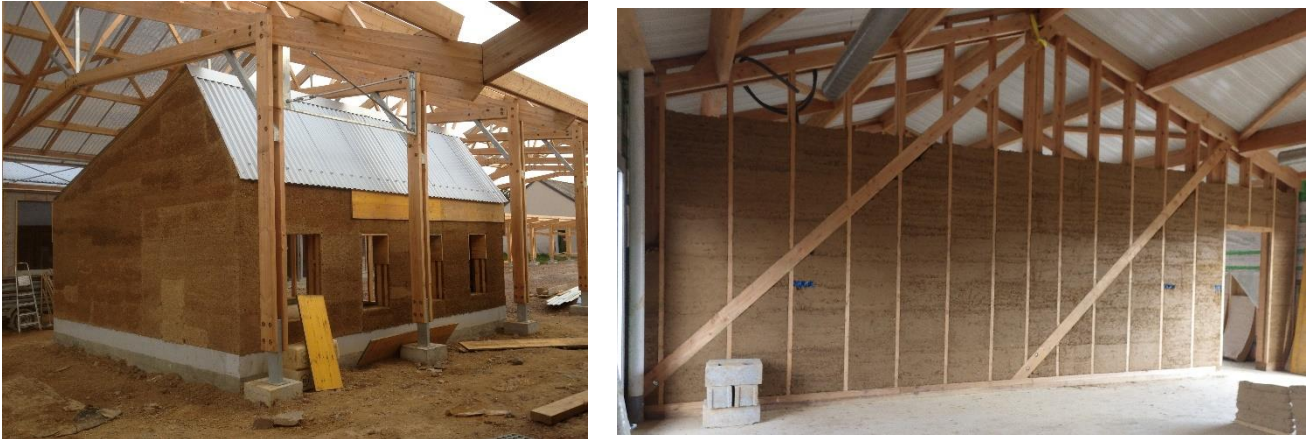
Figure 15 - Le calme après le chantier, photo extérieure de la bibliothèque (à gauche) et d'un mur de séparation entre deux salles de classe (à droite)
