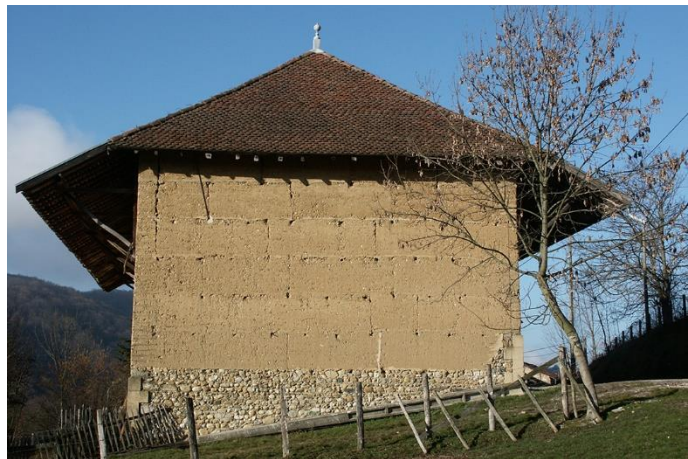
Figure 3 - Maison en pisé dans le Nord de l'Isère
