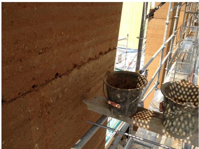
Figure 10 - Photo sur l'échafaudage du chantier de Confluence, avec un seau de terre et un seau d'eau
