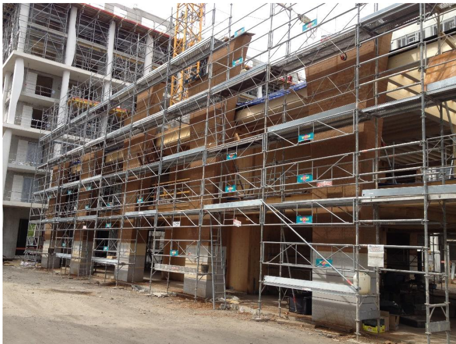
Figure 6 - Photo du chantier de Confluence au mois de juin
