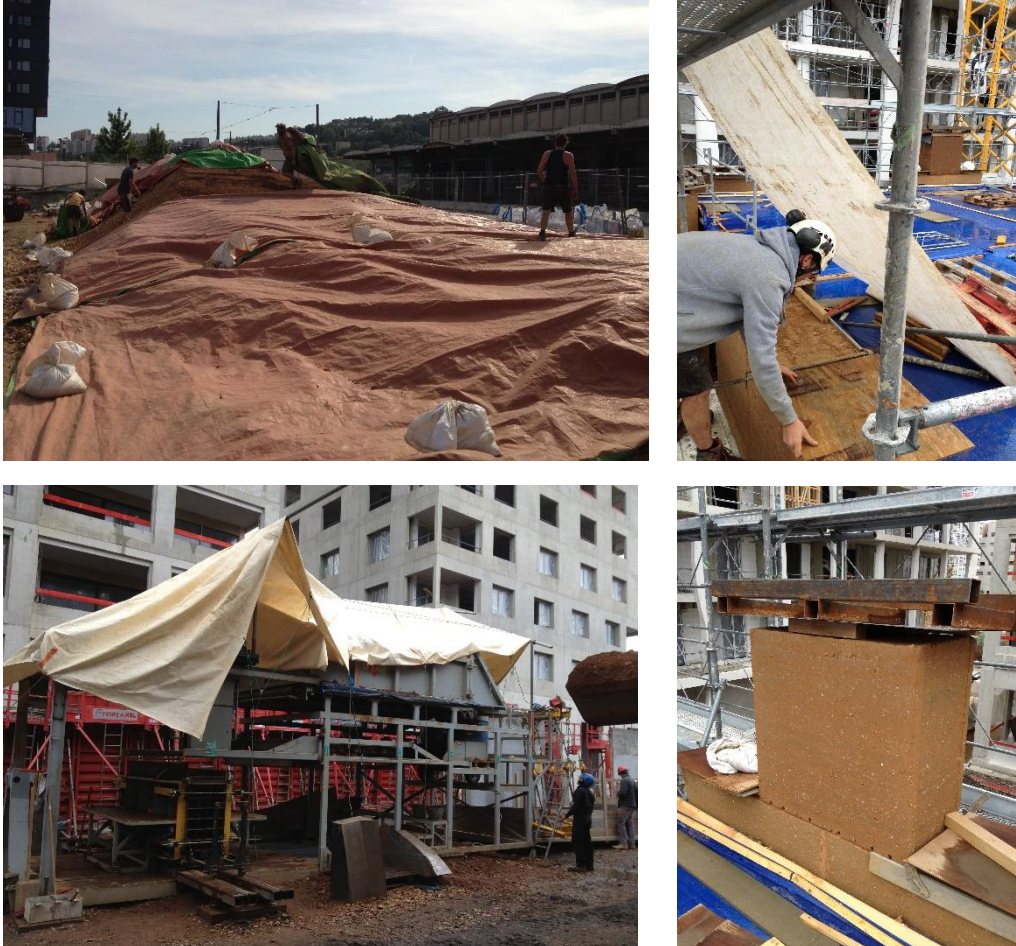
Figure 16 - Florilège de dispositifs techniques pour protéger la terre de la pluie, partout où elle passe
