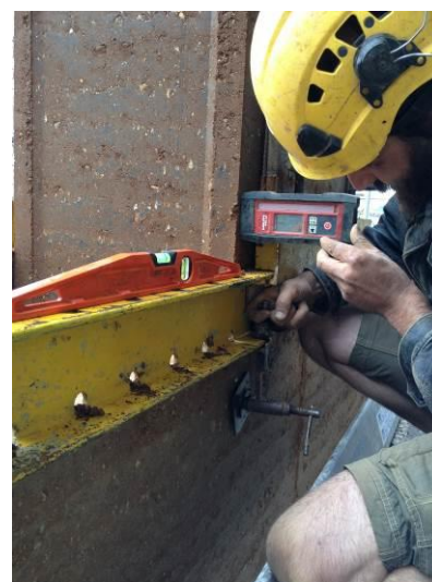
Figure 8 - Jean-Baptiste ajustant un bloc de pisé avec une règle (posée sur le fer jaune et un laser, dans la main
